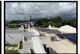
Sistema Integrado por Terra Alta Engineering 10.8 Kw DC / 22.8 kWh (18.24 kWh @ 80% DOD)
