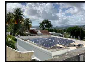
Sistema Integrado por Terra Alta Engineering 10.8 Kw DC / 22.8 kWh (18.24 kWh @ 80% DOD)
